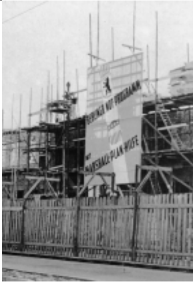
Wiederaufbau mit dem „Man of the Year“ 1943 und 1947: George Catlett Marshall
